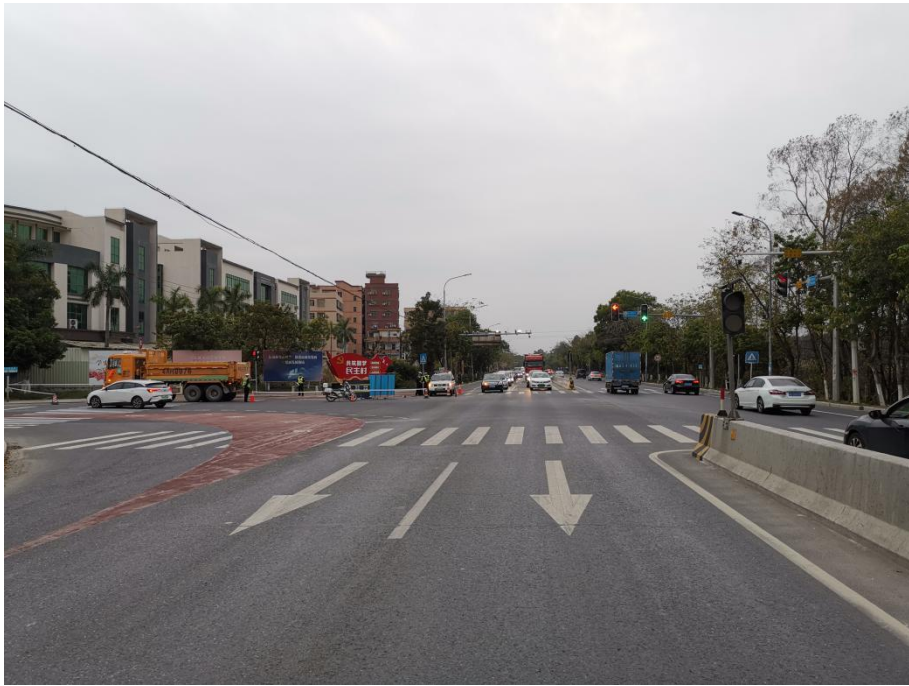
图 2：现场由东往西拍照：显示路面标线情况、路中设有水泥分隔带情况以及“危险区域”红色标识情况。
