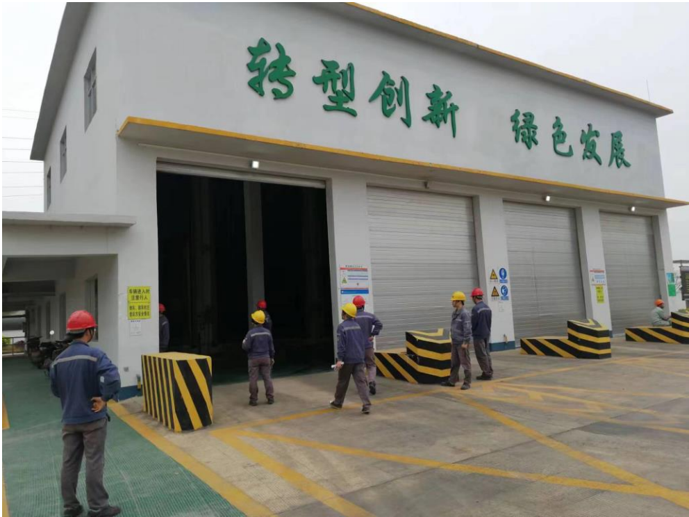
图 4.3-11 干化污泥储存室
