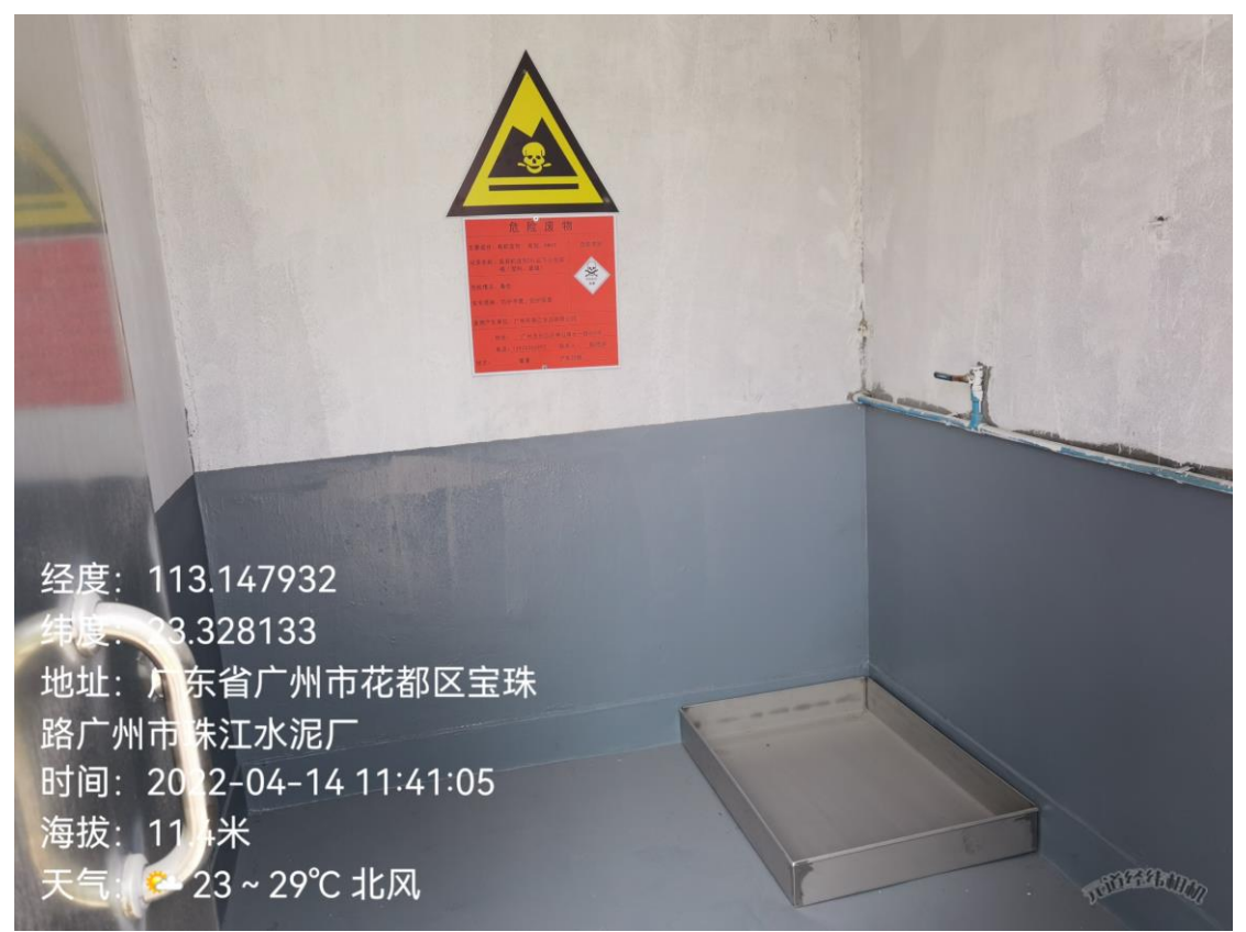
图 4.3-17 危险废物仓库
