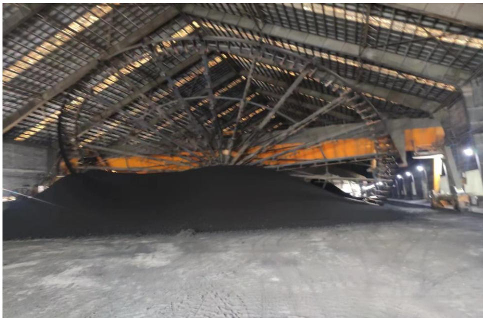
图 4.3-10 均化库煤储存
