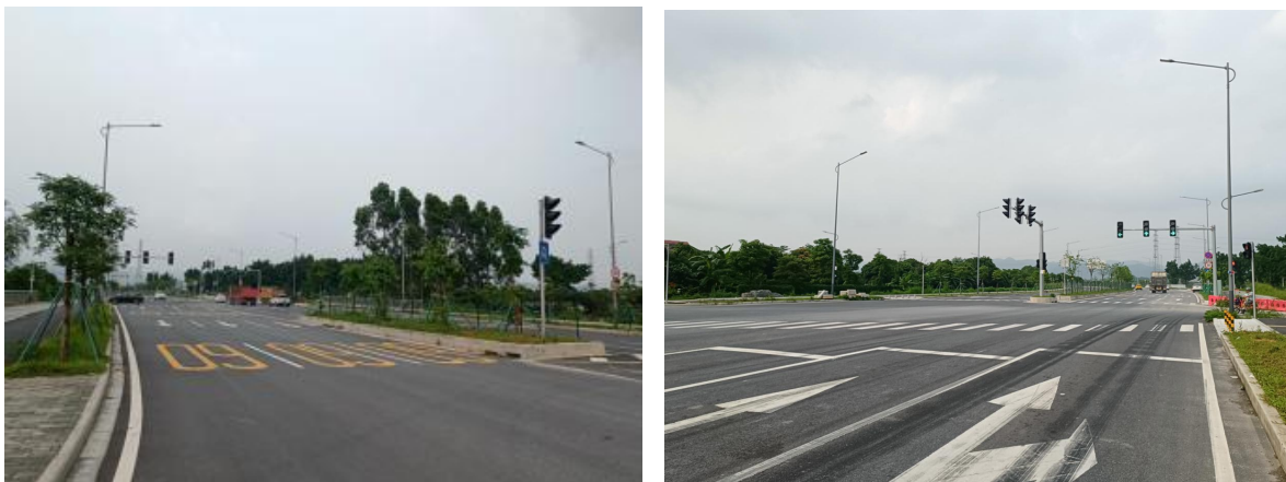
上图为联港大道安全设施设置情况
