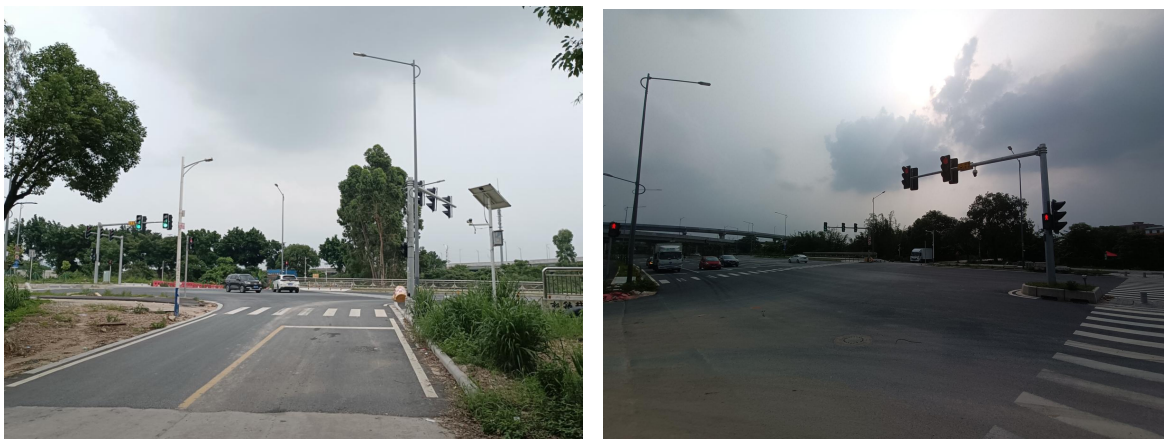
上图为大东街安全设施设置情况
