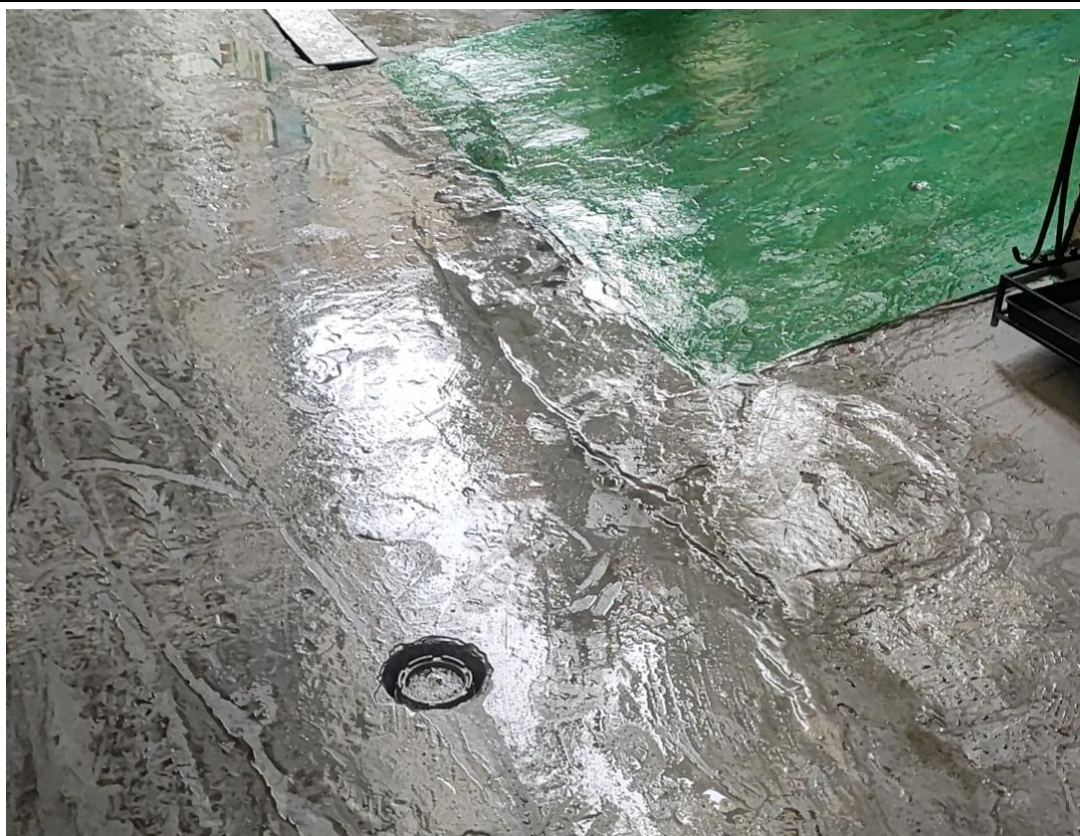
污水站监测井
