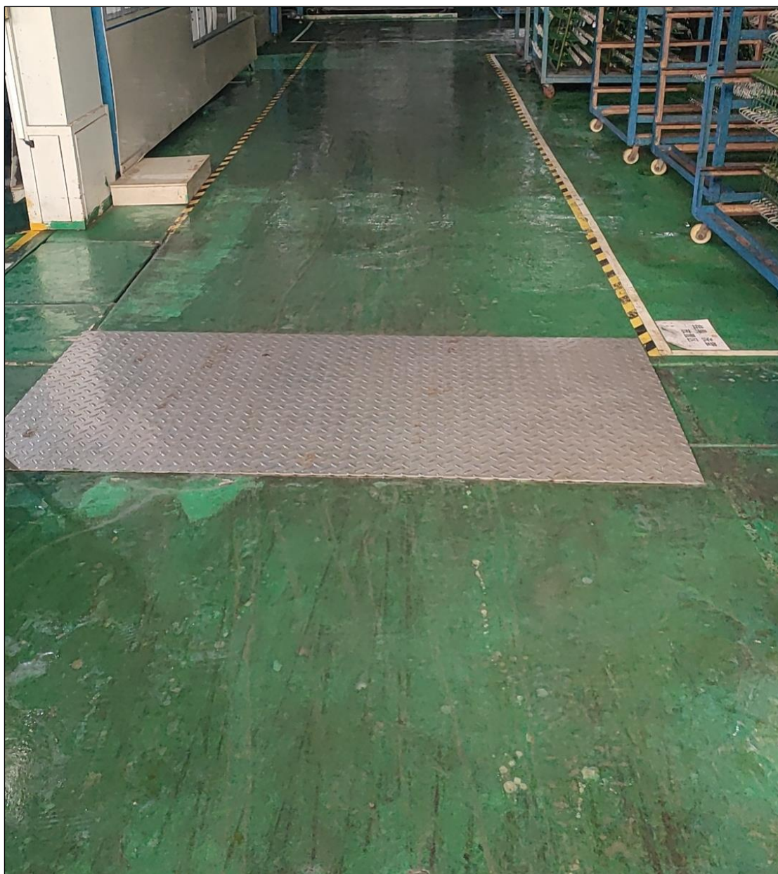
图5.1 地面硬化和防渗涂层
