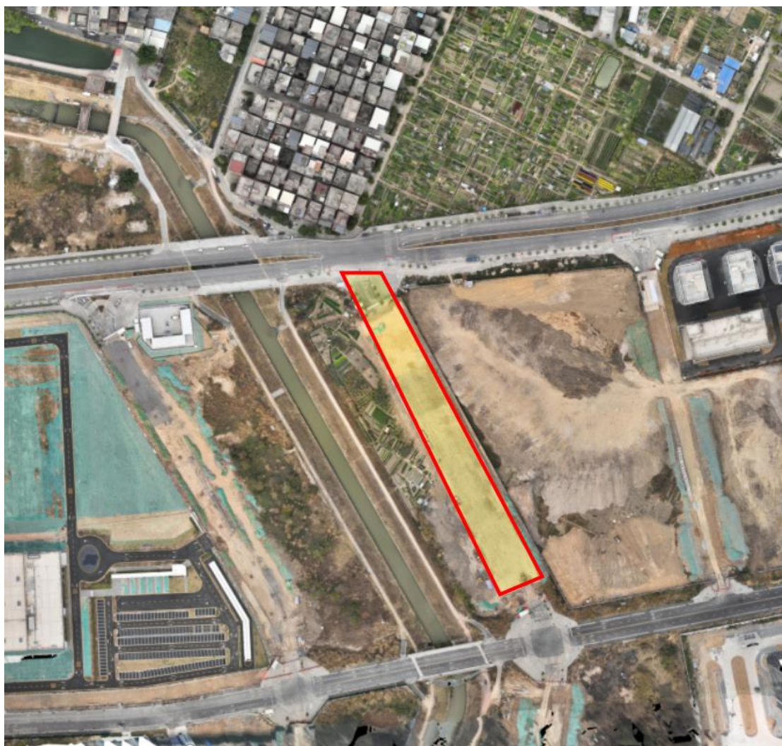
新雅街：新雅街新村塘围（治安室）东南 172 米的永利路段。
