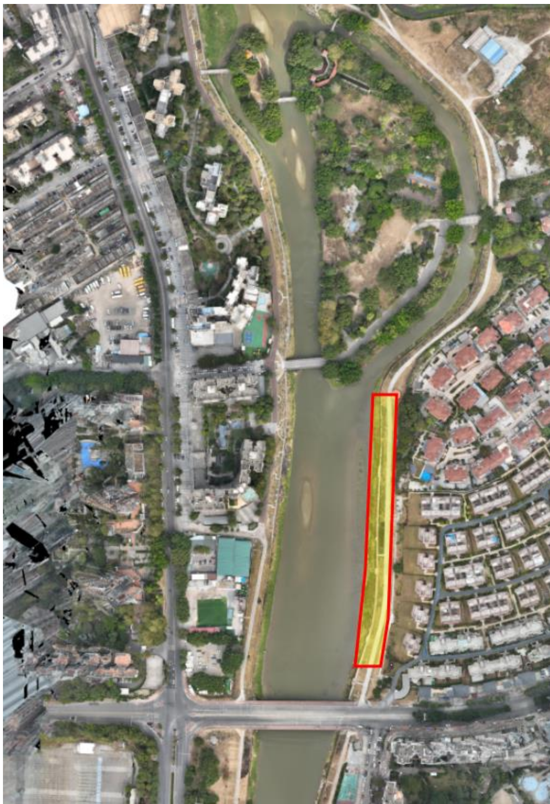
新华街：天马河东堤（望亭桥以北，离桥 50 米）
