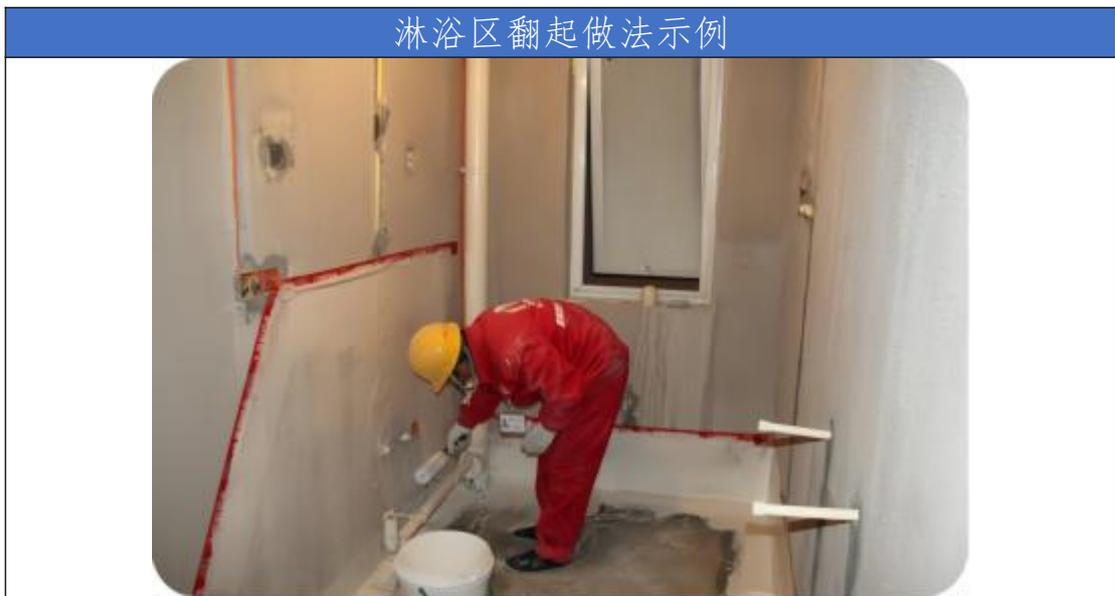
2.涂膜防水层分 2-4 遍薄涂，每遍干燥后再施工下一道涂膜，总厚度不小于 1.5mm 且满足设计厚度要求（现场实测厚度、粘结强度）。
