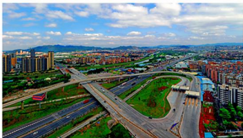
迎宾立交 新华互通立体交叉工程完工，城区交通路网进一步改善，往西出行更便利。
