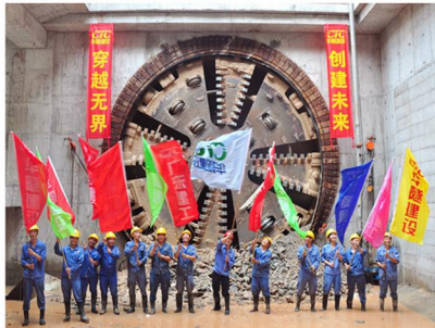
地铁九号线首条隧道顺利贯通
