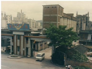
1991年，赤坭镇赤坭水泥厂一角 当年建材工业是我县经济支柱之一
