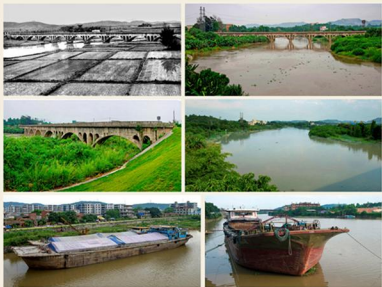
赤泥巴江波槽桥的建桥经历 摄影者：关振伦
